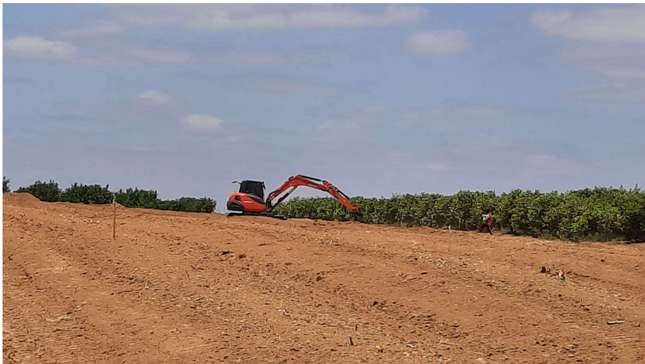
Fotografia do Local da Intervenção - Máquinas a operar no Local a 1 de Junho de 2021
