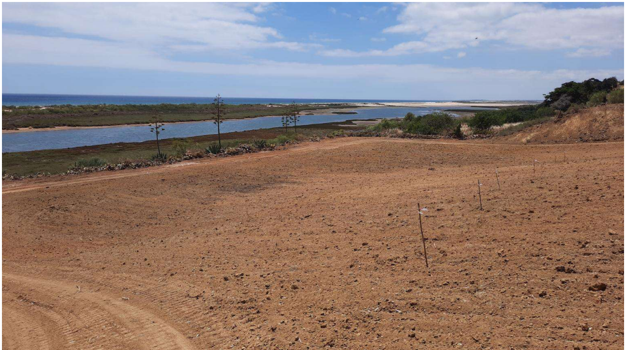
Fotografia do Local da Intervenção - Nivelamento da topografia original na zona da Arriba
