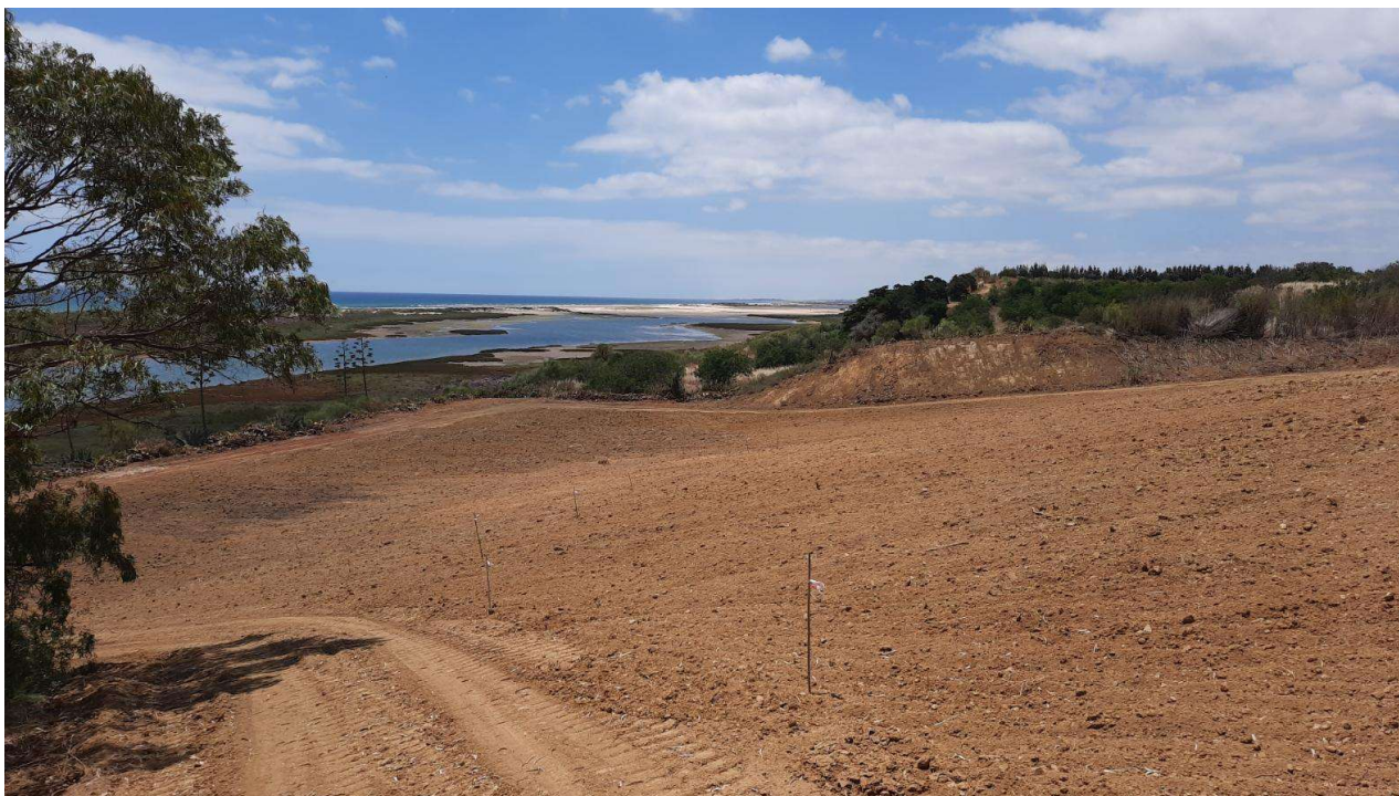
Fotografia do Local da Intervenção - Nivelamento da topografia original na zona da Arriba
